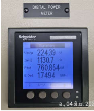
Power Meter ประจำตู้ไฟฟ้าหลัก แต่ละอาคาร
